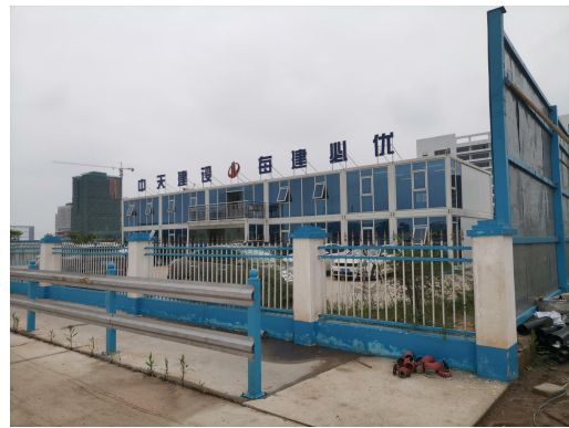
项目厂区内地面图
