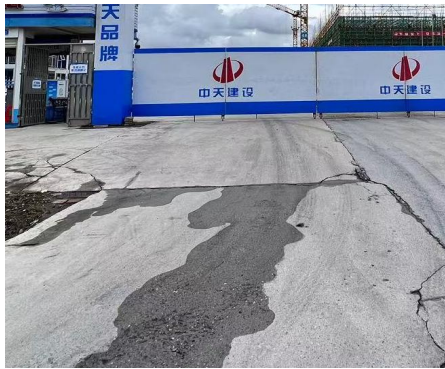
项目厂区门口地面图
