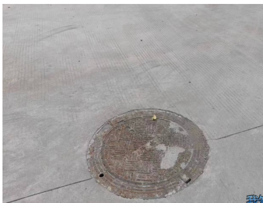
图 3-2 水土保持工程措施照片
