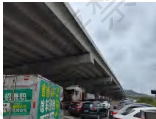
南面隔深岑高速为广东明阳电气股份有限公司
