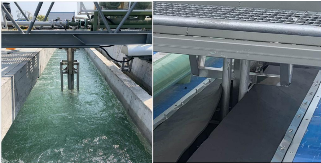
曝气沉砂池密封前
