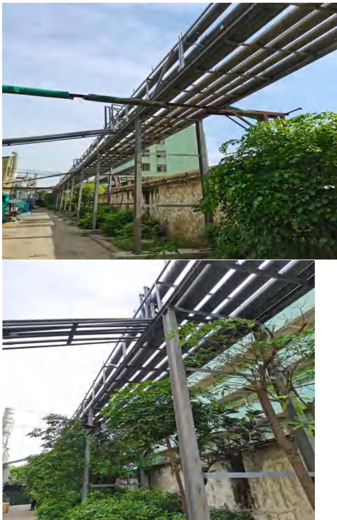
图4.5-17 污水管道（架空段）
