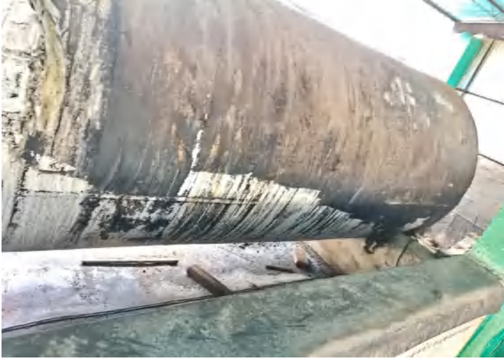
图4.5-2 危险化学品储罐
