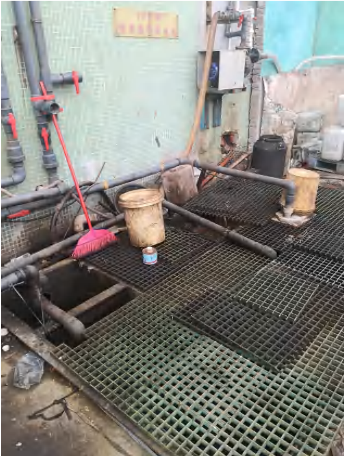
图4.5-18 污水管道（埋地段）
