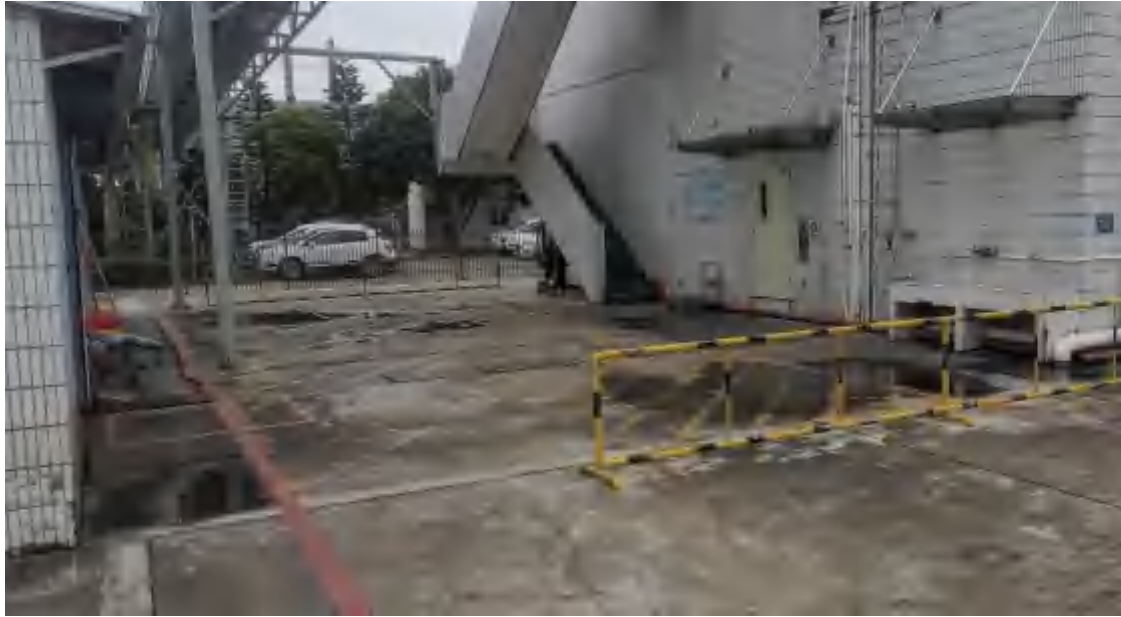
图 4.2-5 应急池现场排查照片
