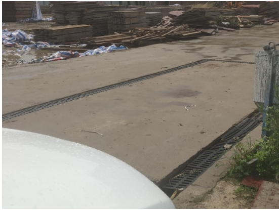
施工出入口洗车槽
