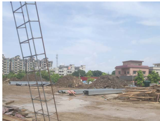
主体工程区围墙工程开挖
