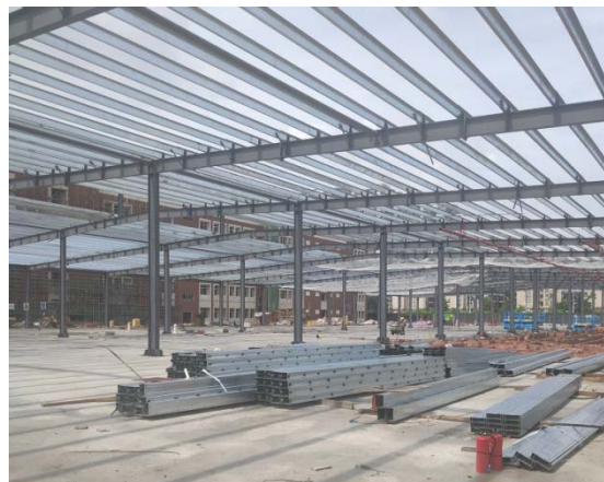
主体工程区厂房6建设现状
