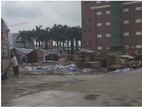
施工营造区材料堆放区
