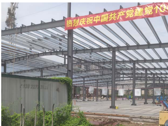
主体工程区厂房6建设现状
