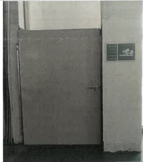
一般固废暂存点
