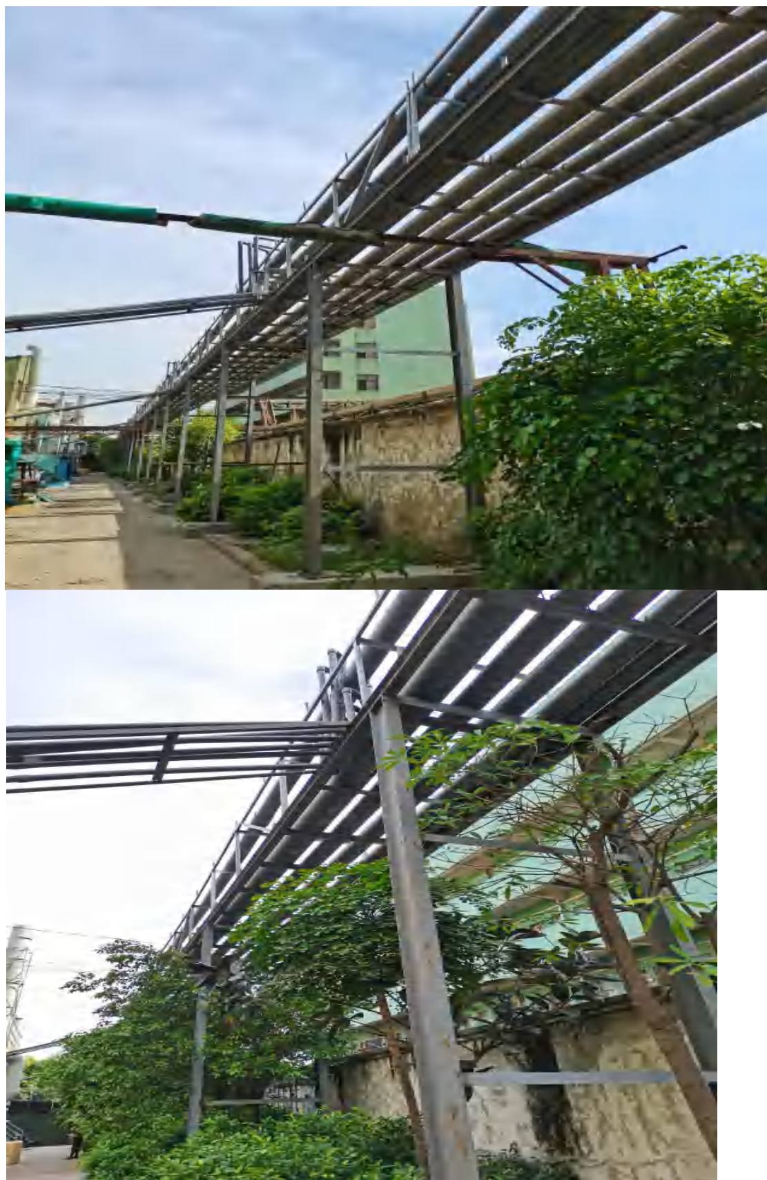
图4.5-17 污水管道（架空段）
