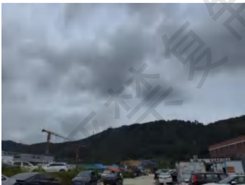
东面广东明阳电气股份有限公司成套厂区
