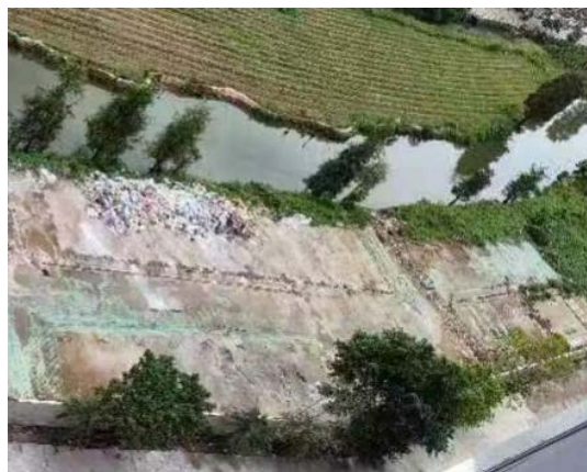
施工营造区(保留硬地)(2023年10月)
