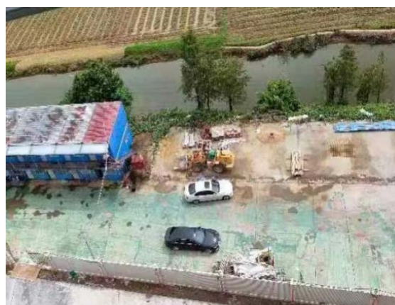
施工营造区(保留硬地)(2023年10月)
