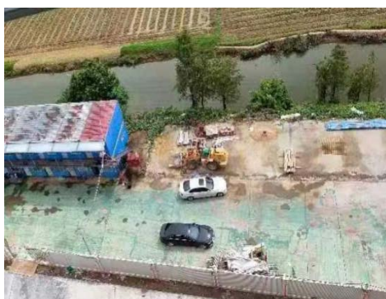
施工营造区(保留硬地)(2023 年 10 月)
