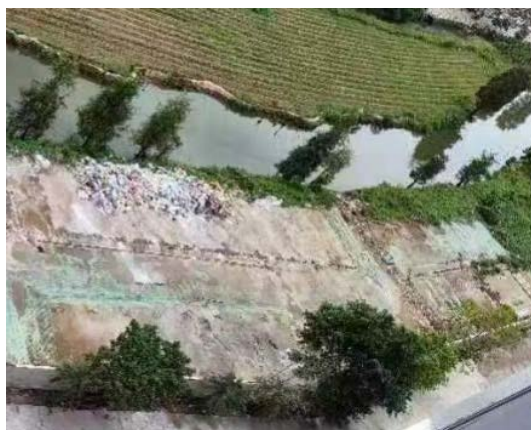
施工营造区(保留硬地)(2023 年 10 月)
