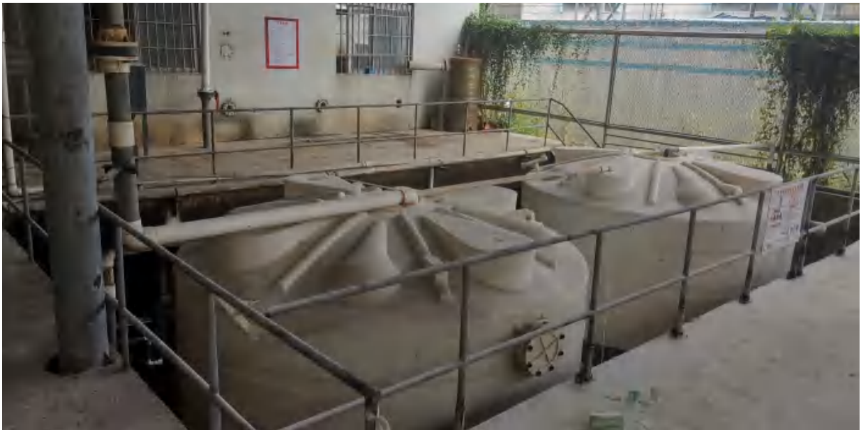
图 4.5-1 次氯酸钠储罐现场排查照片
