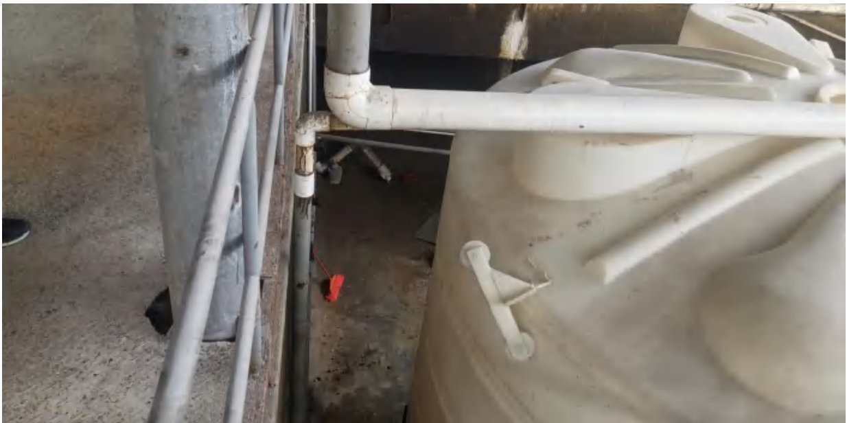
图 4.5-2 储罐地面硬化情况现场排查照片
