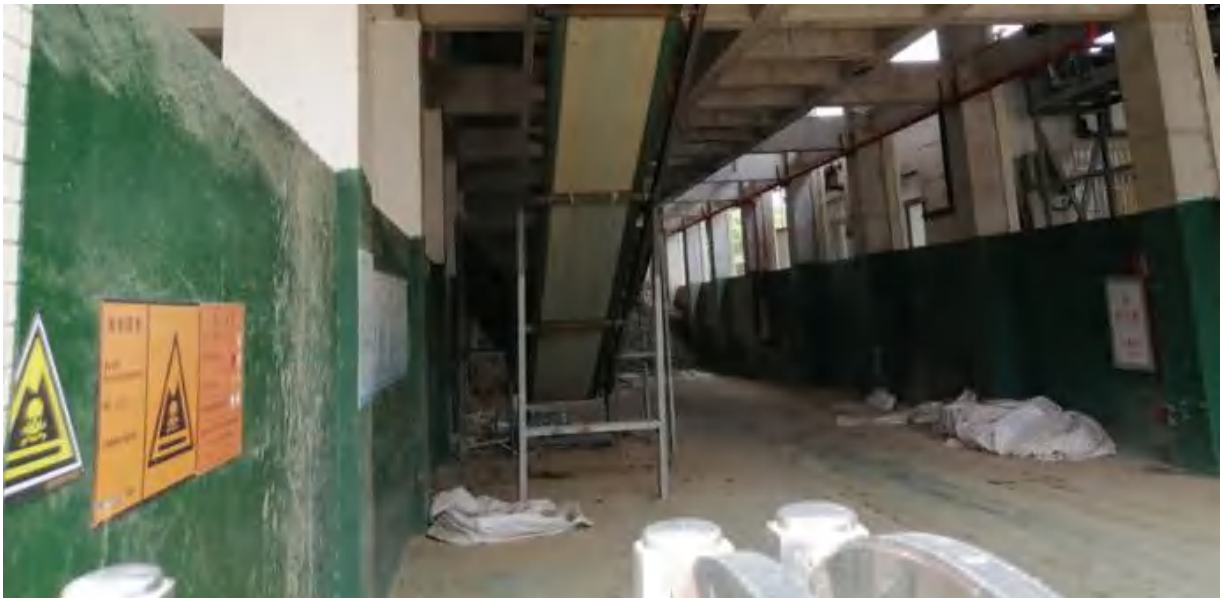
图 4.5-8 固体废物贮存区现场排查照片
