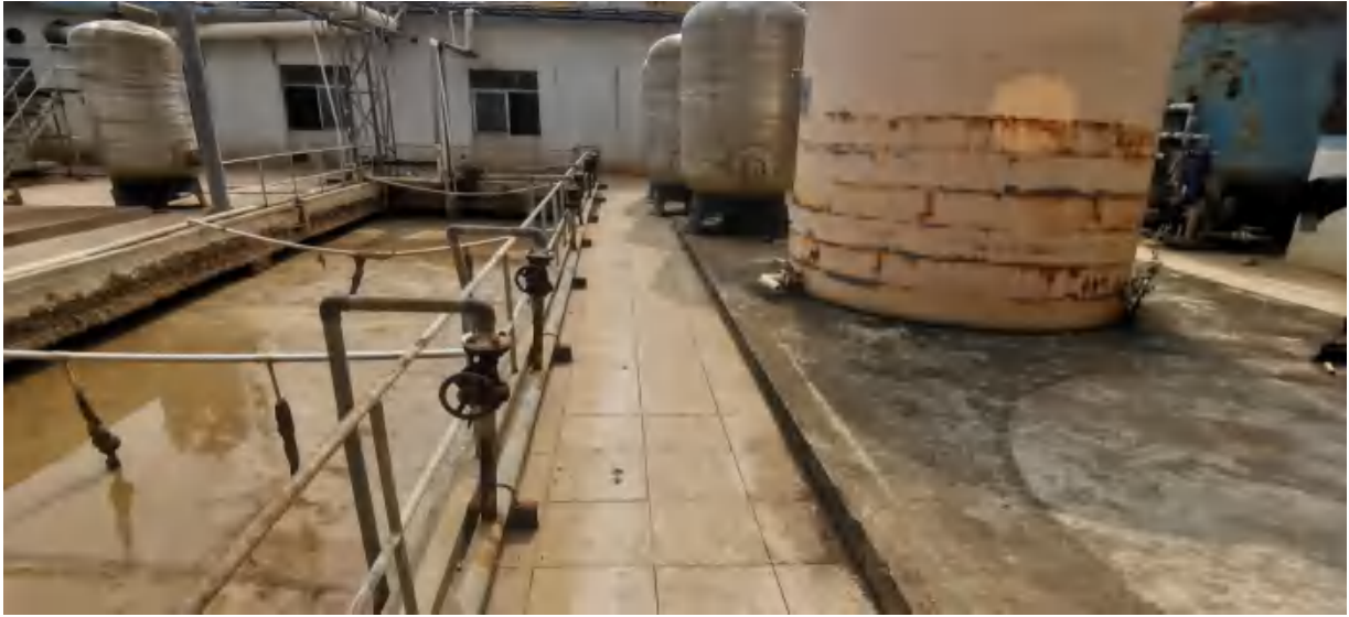
图 4.5-9 应急设施区域现场排查照片 1
