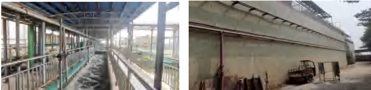
图 4.5-4 废水治理设施池体现场排查照片
