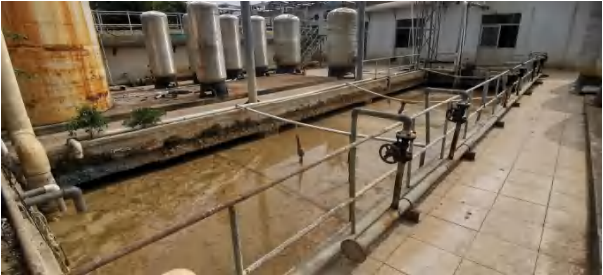
图 4.5-10 应急设施区域现场排查照片 2
