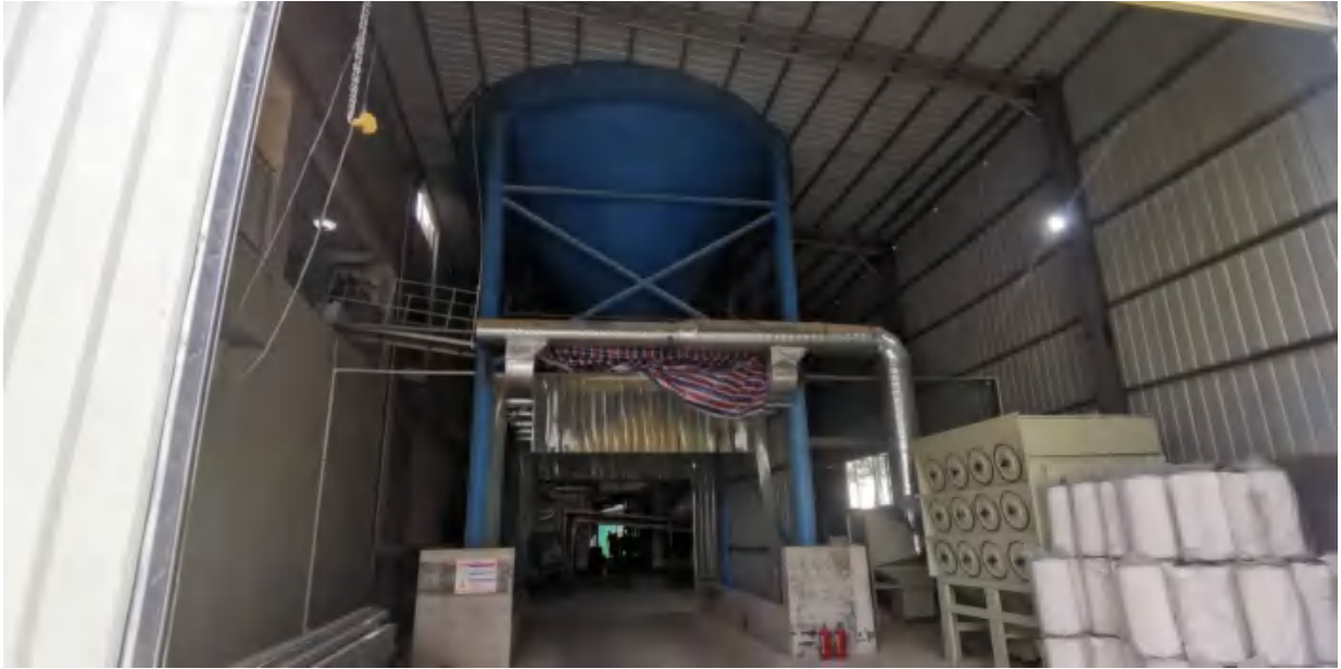
图 4.5-7 固体废物贮存区现场排查照片
