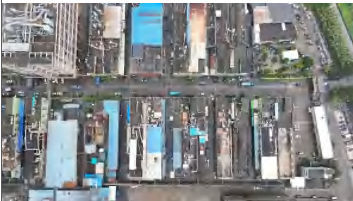
地块西面东锐公司电镀车间、废水处理站航拍图
