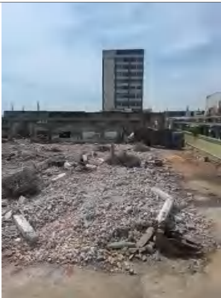
拆除施工过程
