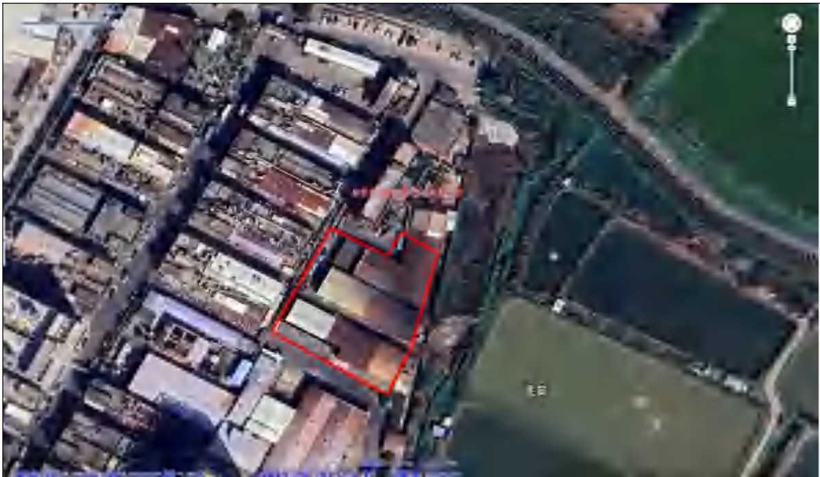
2024 地块北面东锐公司宿舍楼、河水净化设施航拍图（与 2018 年相比无明显变化）
