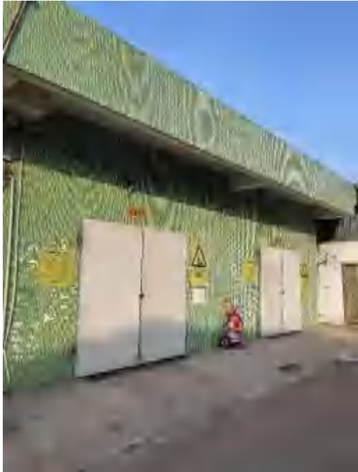
危险废物仓库
