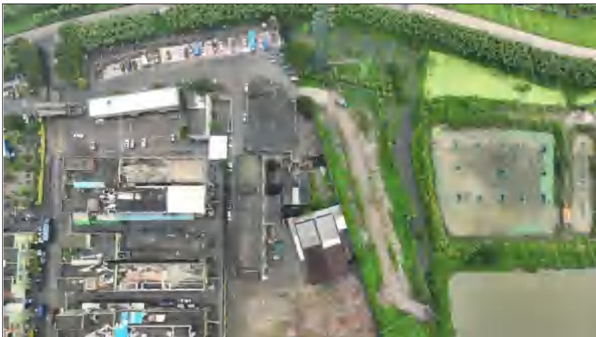
地块北面东锐公司宿舍楼、河水净化设施航拍图
