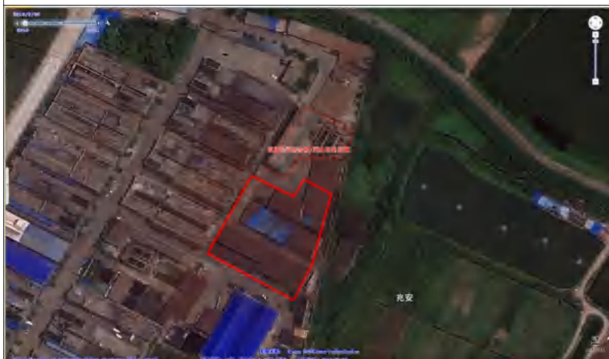
2010 地块北面东锐公司宿舍楼、河水净化设施航拍图（与 2006 年相比无明显变化）
