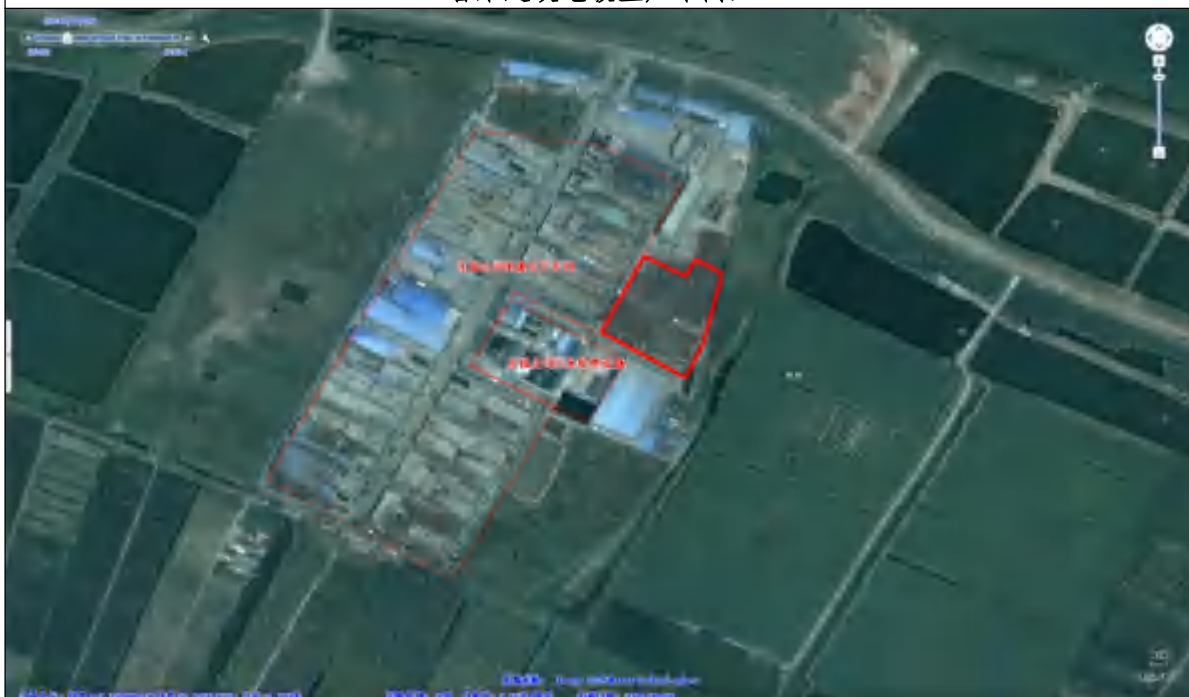
2006 地块西面东锐公司电镀车间、废水处理站航拍图（东锐 A、B、C 区已建成电镀生产车间）
