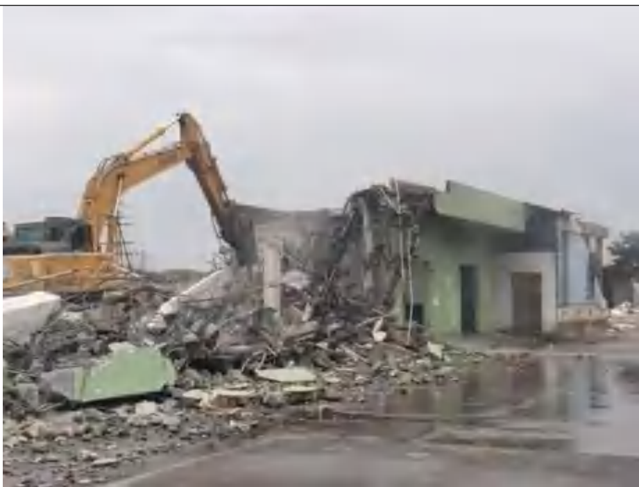
拆除施工过程
