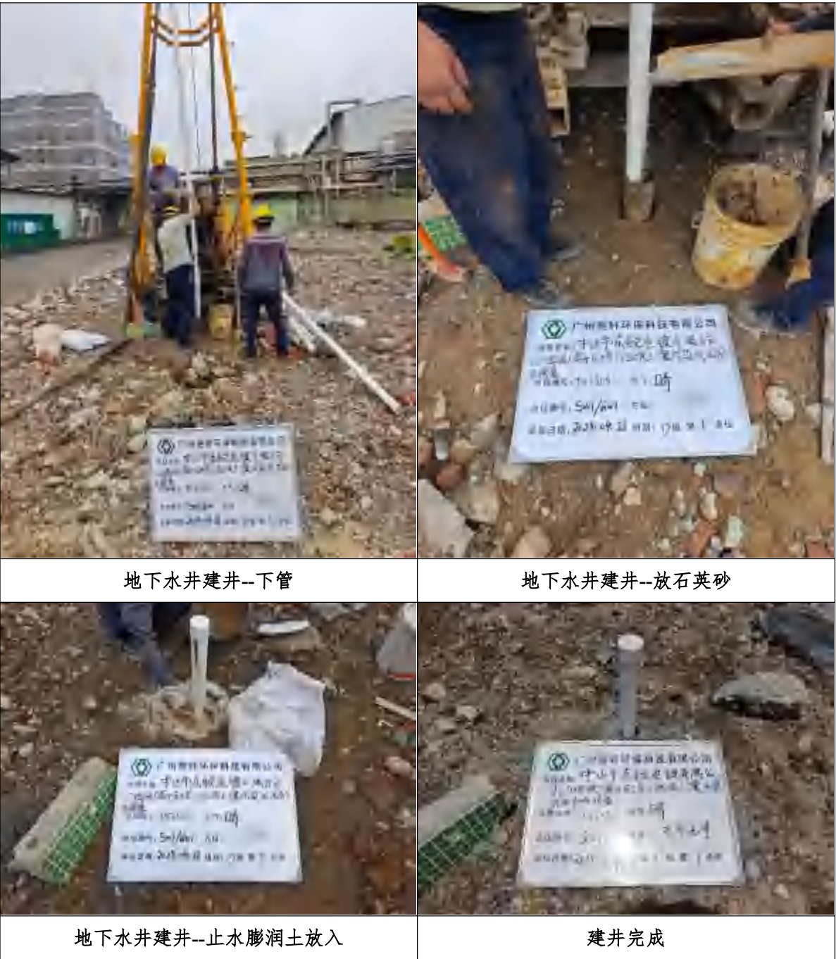
图 4.2-3 地下水建井照片
