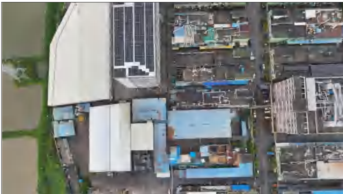
地块南面东锐公司电镀生产车间航拍图
