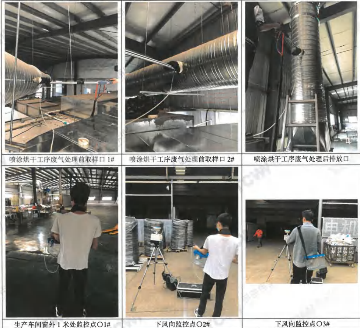
附图：部分现场检测照片
