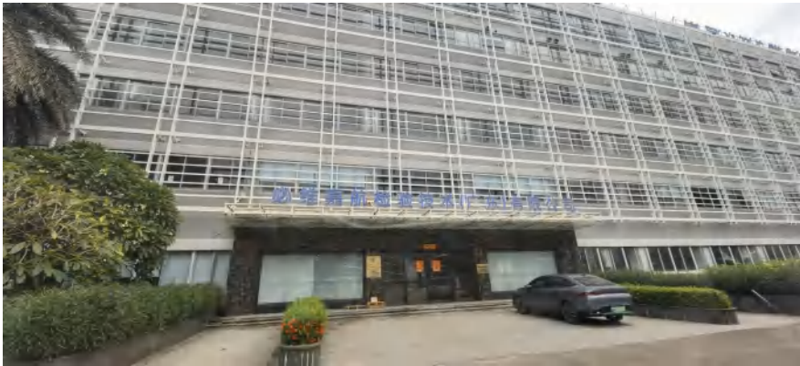
项目厂界西面
