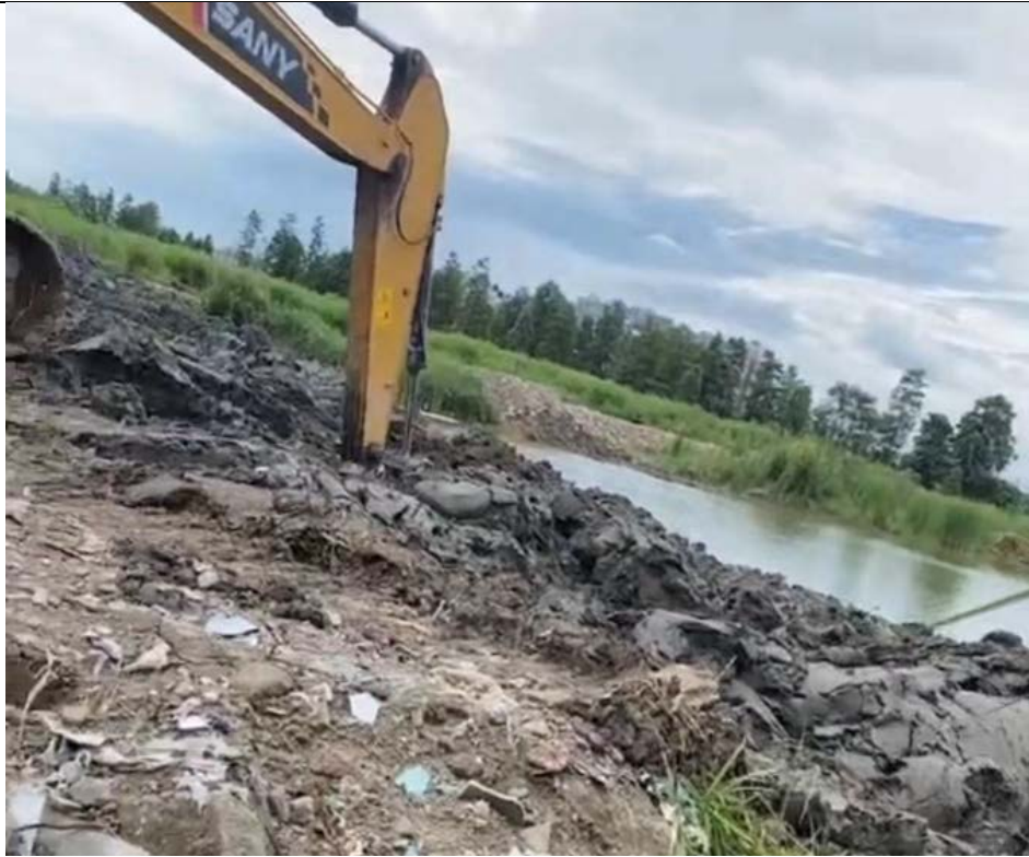
弃土接收点现场图片
