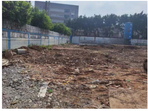
主体工程区现状
