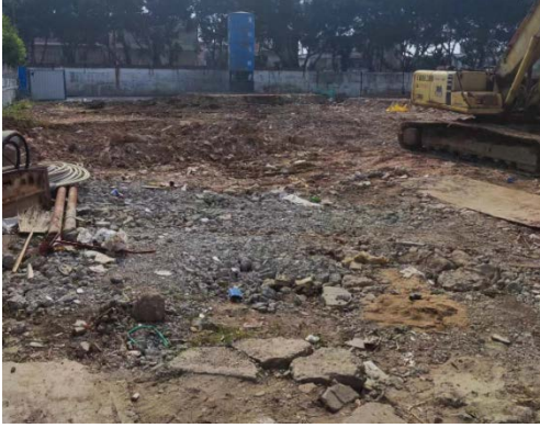
主体工程区现状
