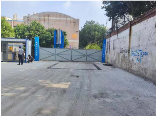
施工出入口洗车槽
