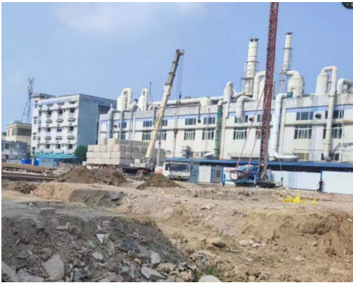
主体工程区现状
