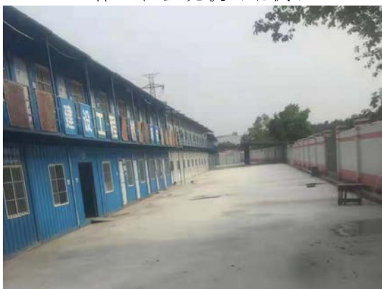
施工营造区现状（已建成）
