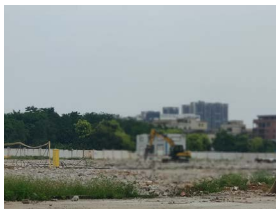
主体工程区现状（西侧）
