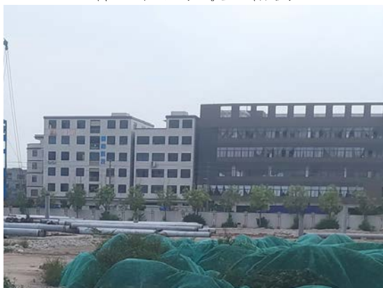
主体工程区现状（北侧）
