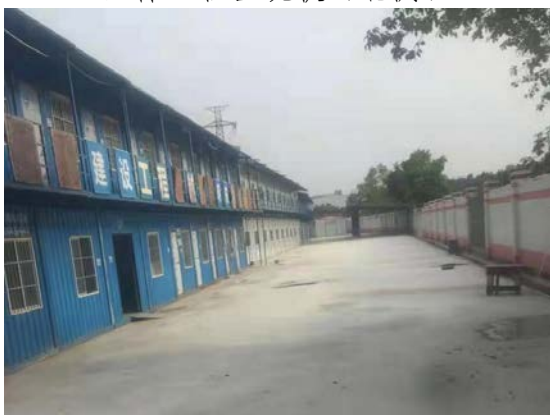
施工营造区现状（已建成）
