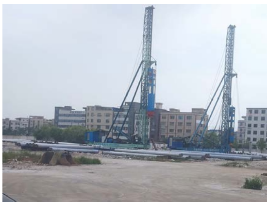
主体工程区现状（南侧）
