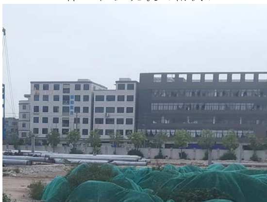
主体工程区现状（北侧）
