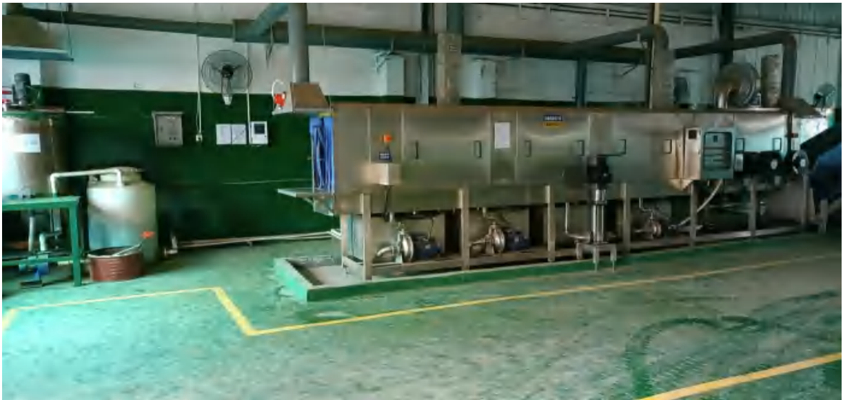
图 4.5-8 危险废物贮存区现场排查照片
