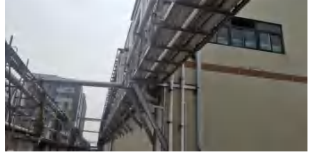
图 4.2-6 废水治理设施管网现场排查照片
