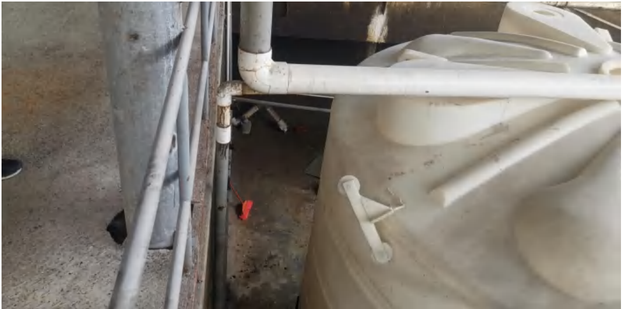
图 4.5-2 储罐地面硬化情况现场排查照片
