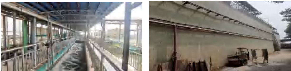
图 4.5-4 废水治理设施池体现场排查照片
