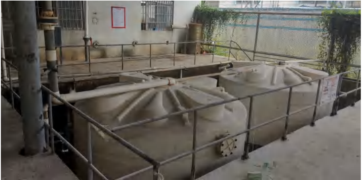
图 4.5-1 次氯酸钠储罐现场排查照片
