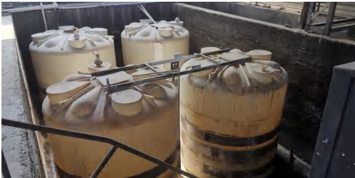
图 4.5-3 硫酸储罐现场排查照片
